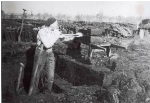
Fig. 73 De turven worden vanuit de kuil op de kruitwagen (klotkar) geladen
